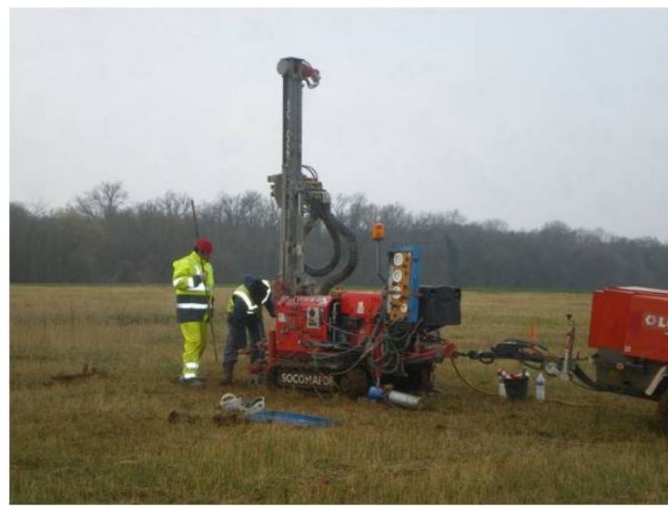
Forage effectué lors d'une étude hydro-géologique
